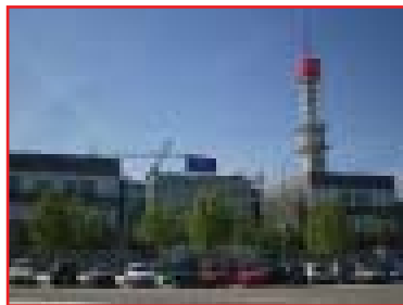
RADIO CASTILLA -LA MANCHA, Toledo, Edificio 2
